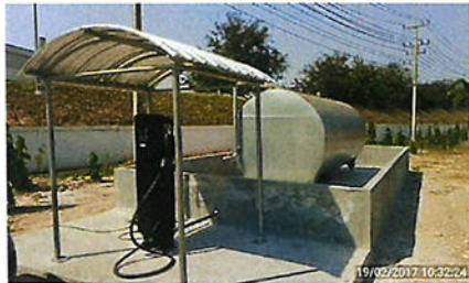
ภาพจุด ② จุดเก็บน้ำมันดีเซล ขนาด 300 ลิตร
